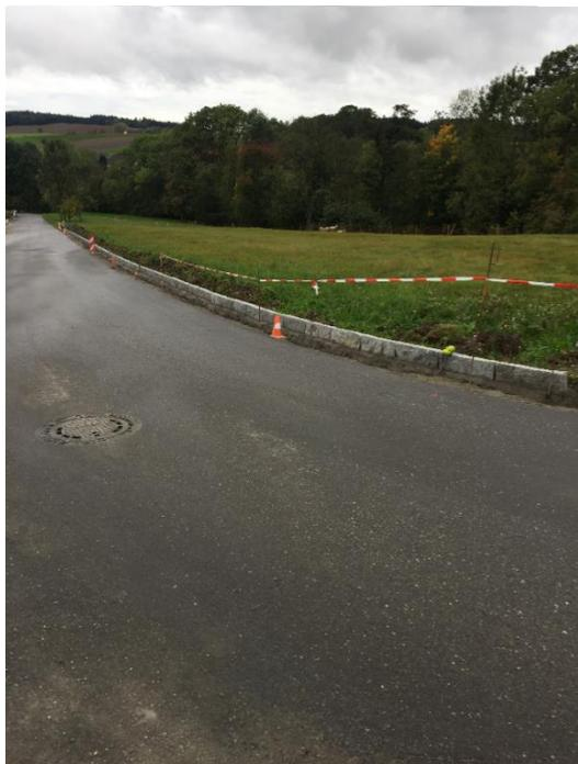
Die Oberflächenwasserführung wurde auf einer Länge von ca. 130 m mit einer Randleiste hergestellt.
