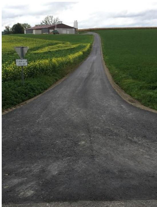
Es wurden 350 m neu asphaltiert; 2020 ist für den Rest eine Spritzdecke geplant.
