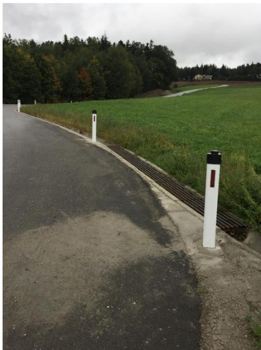
Die Oberflächenwasserführung wurde im oberen Bereich mit Rasengittersteine und im unteren Bereich mit einer Länge von ca. 120 m mit Halbschalen hergestellt.
