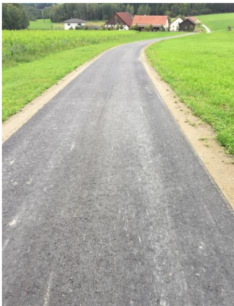
Der *Güterweg Weizenau* wurde über eine Länge von circa 1.300 m neu asphaltiert und 2020 ist für den Rest eine Spritzdecke geplant.
